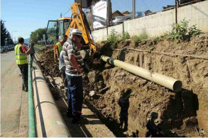
Završeni su radovi na izgradnji separate kanalizacione mreže u ulici Kurta Schorka, od Hidrogradnje u dijelu ulice Safeta Zajke do spoja sa Brezanskom ulicom u Brijesću.
